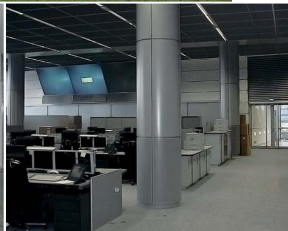
Baustützenverkleidung als luftführendes Element mit decken-integriertem Kanalsonderformstück und Sockel-Quell-Luftauslass
