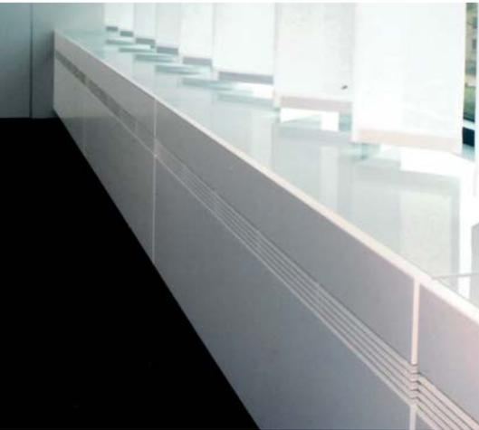
Heizkörperverkleidung mit siebbedruckter Glasabdeckung
