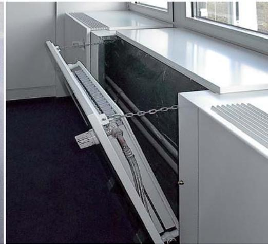
Heizkörperverkleidung mit klappbaren Revisionsöffnungen
