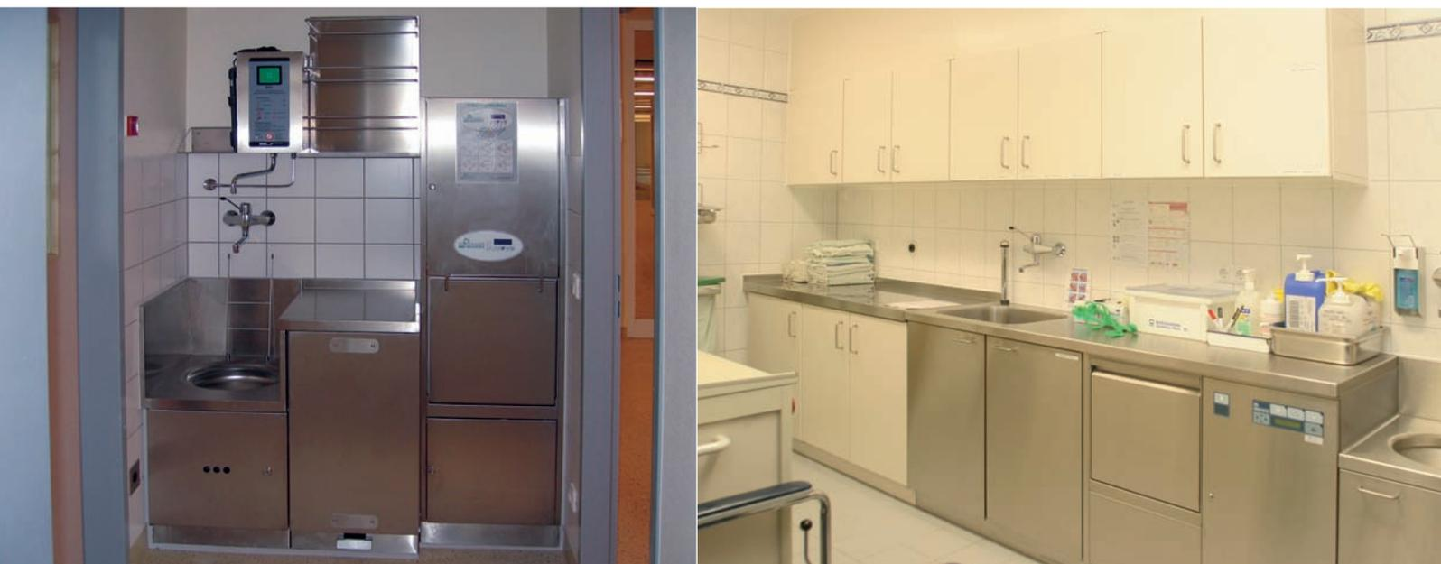
▲ Pflegekombinationen mit integrierten Reinigungs-/Desinfektionsautomaten, Hospitalausgüssen, Abfallauszugsschrank, Desinfektionsmittelzumischgeräten und Lagereinheiten für Urinflaschen und Steckbecken
